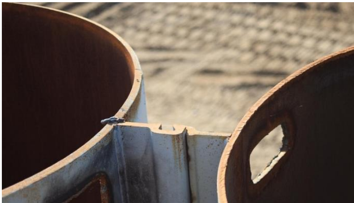
Figur 6 Skjøting mellom rørene i rørsputtvegg.
